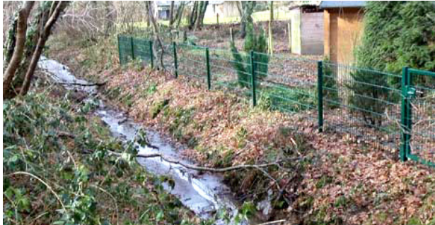
Zaunerrichtung auf Böschungsoberkante
